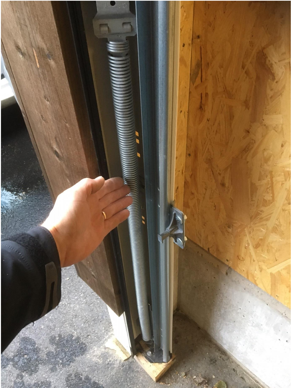
Bild 8 – Rostskyddas med transparent Dinitrol, spraya utan pip på hela fjädern.
