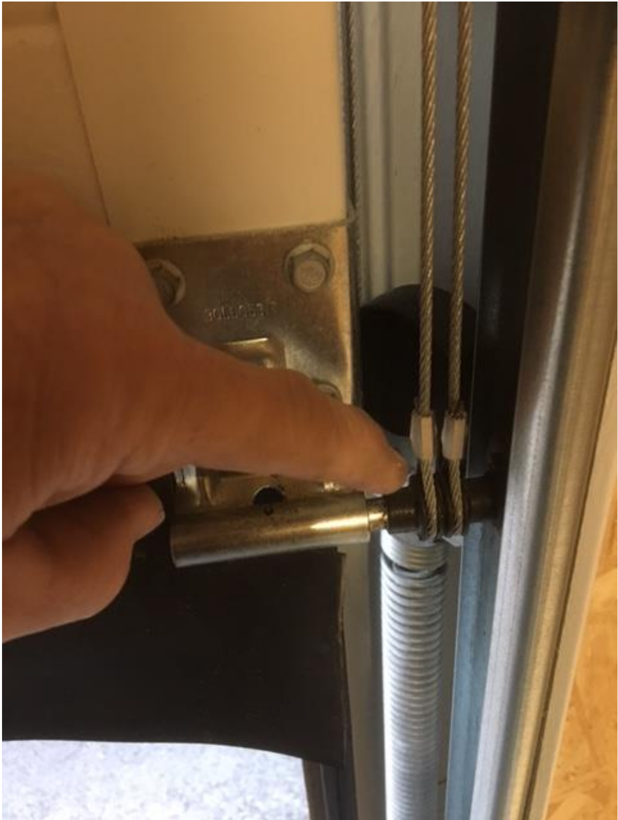
Bild 2 – smörjning med PTFE, spraya lite på och runt den svarta bussningen som vajer öglorna är fästa runt.
