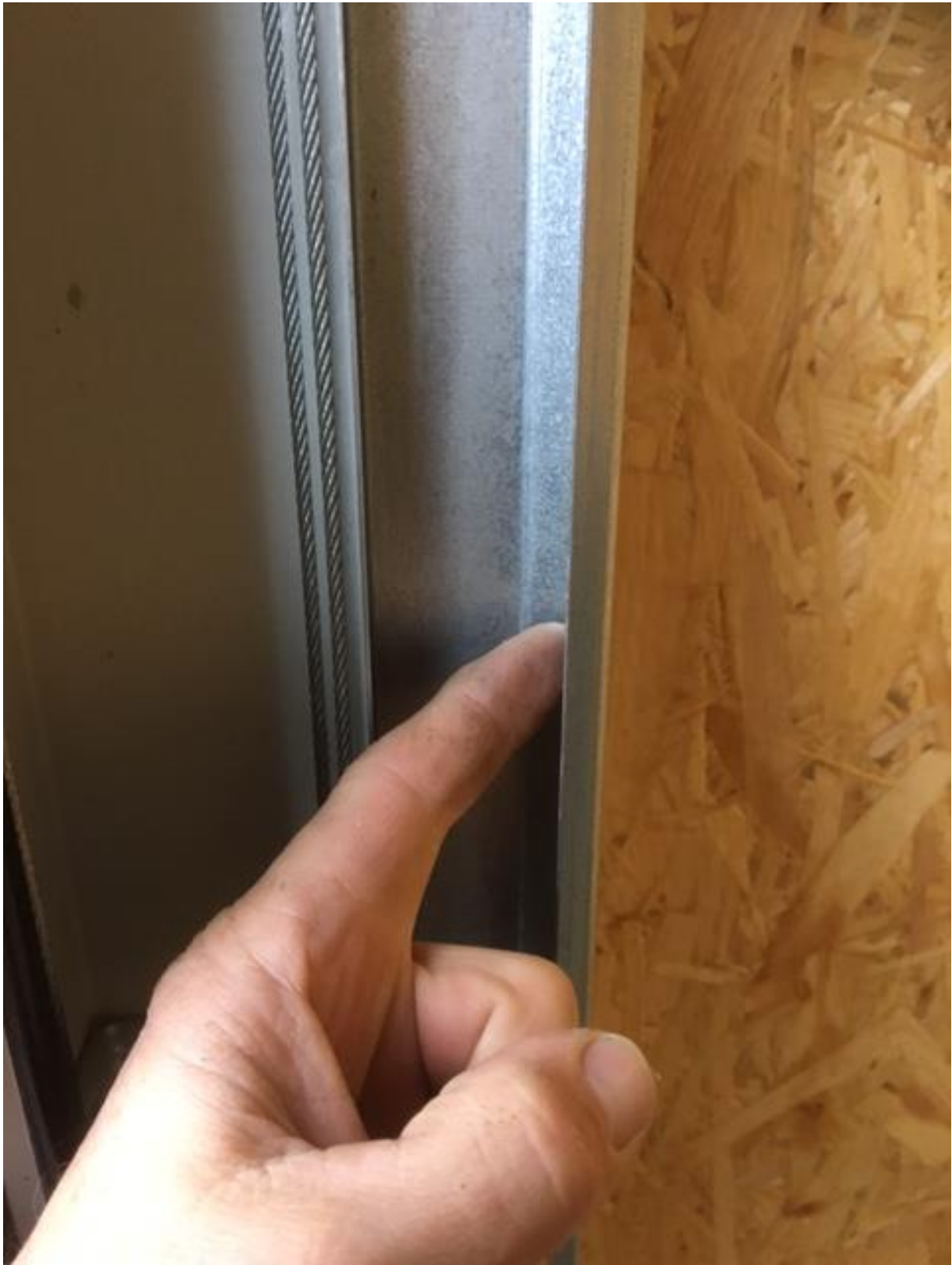
Bild 5 – smörjning med PTFE, spray lite i skenorna där rullen löper, vertikala skenan visad
