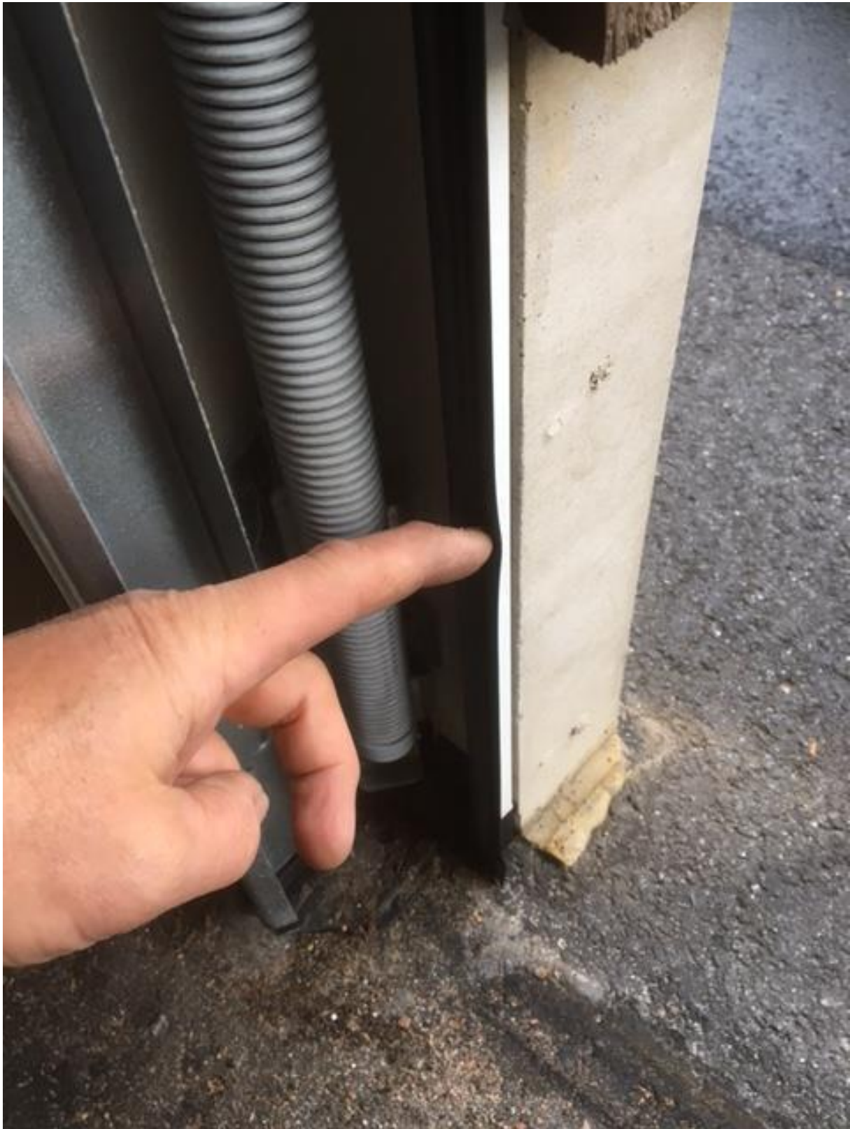
Bild 7 – smörjning med PTFE, spraya lite på den svarta plastlisten längs hela porthöjden, portens utsida glider mot denna när den stänger den sista biten.
