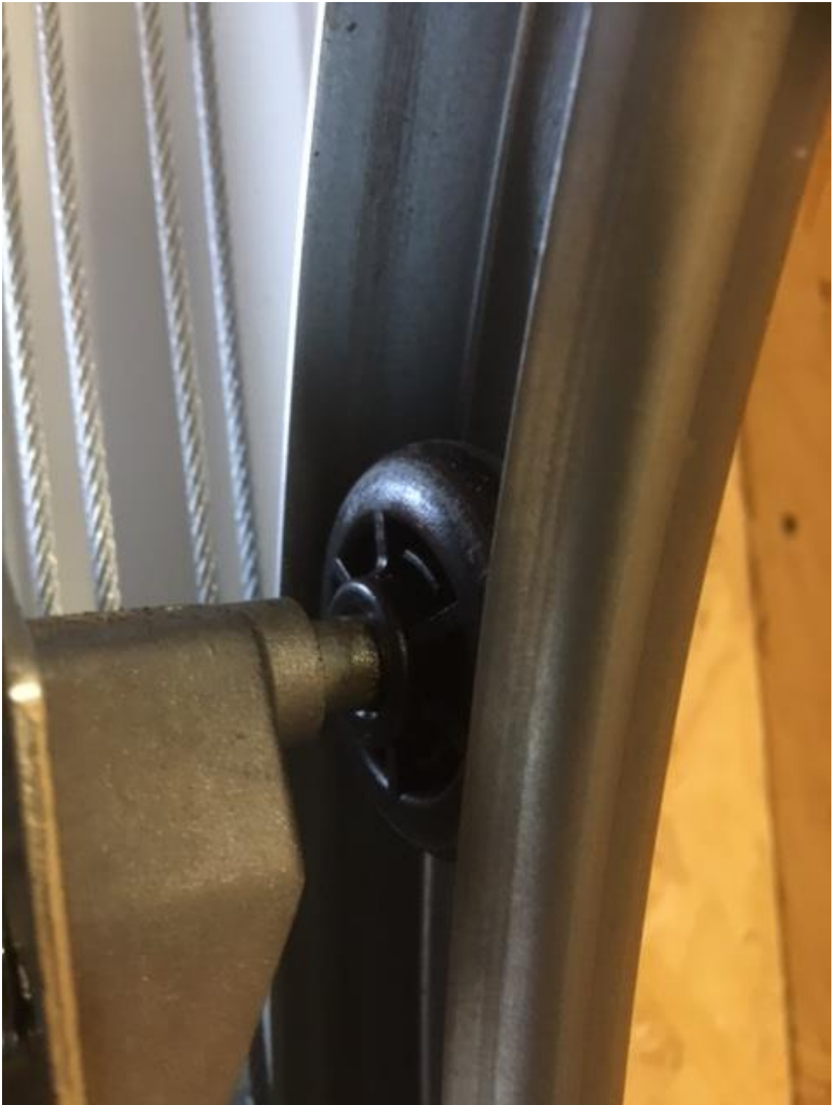
Bild 4 – smörjning med PTFE, spraya lite på rullens axel intill den svarta plastrullen, förbättrar rullens glidlagring och porten rullar lättare.
