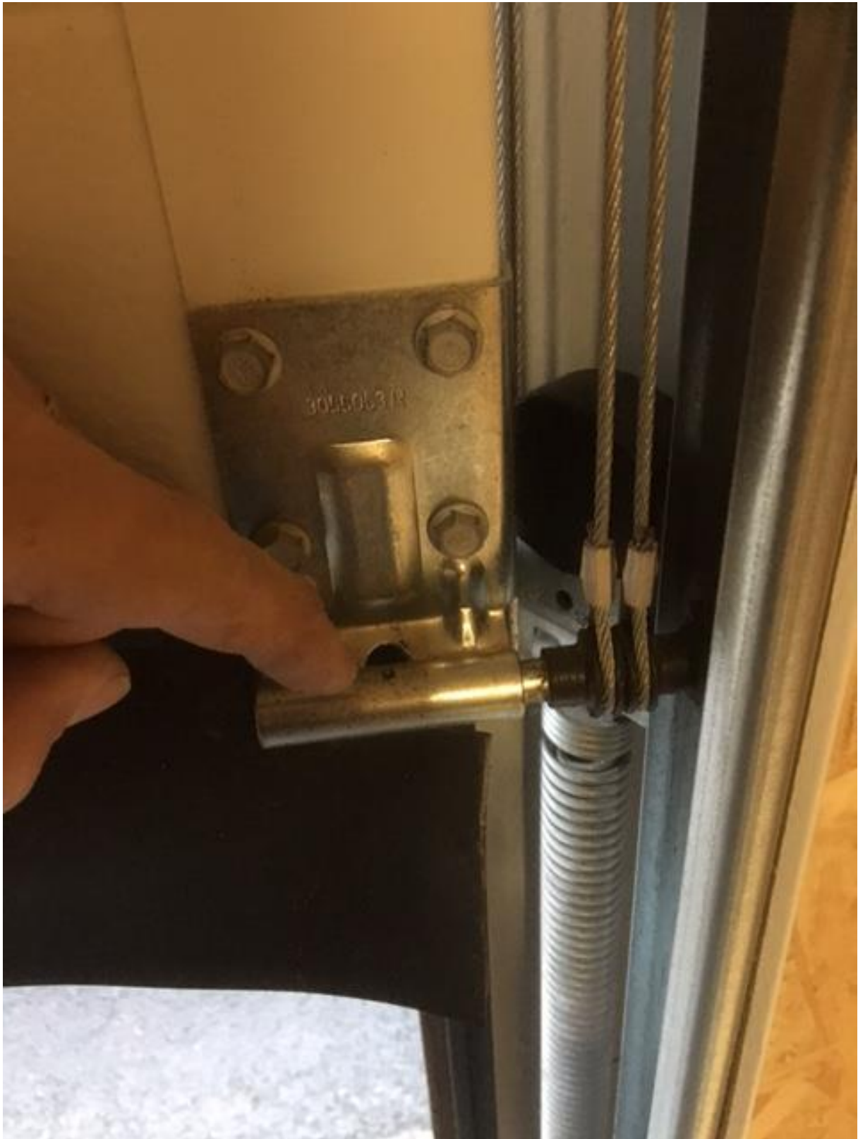
Bild 1 – smörjning med PTFE, använd pipen och spraya i hålet, det underlättar för rullaxeln att röra sig axiellt i rullhållaren.
