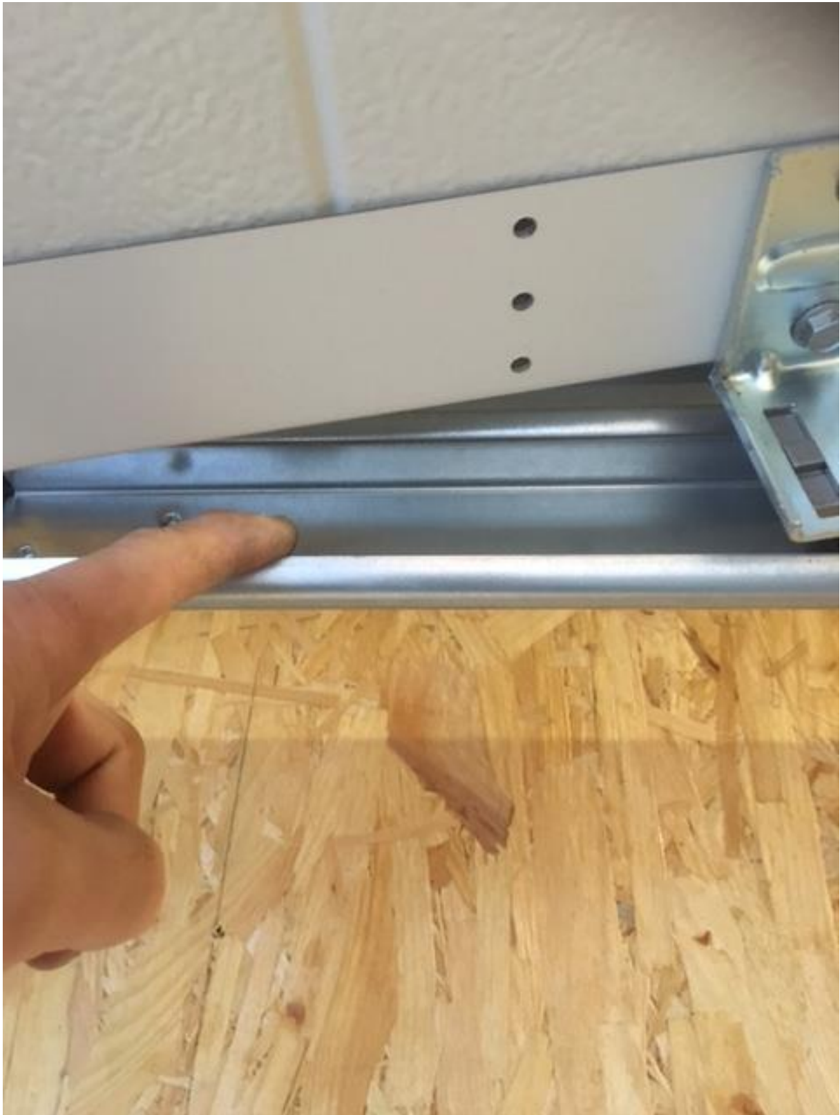
Bild 6 – smörjning med PTFE, spray lite i skenorna där rullen löper, horisontala skenan visad
