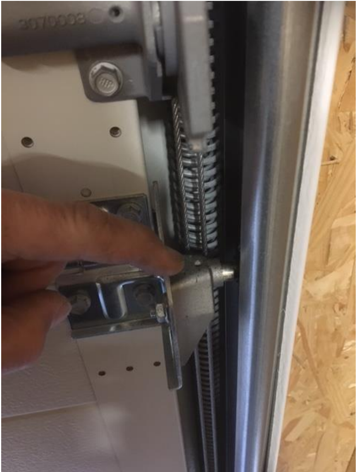
Bild 3 – smörjning med PTFE, spraya med pipen i mellanrullhållarnas hål, underlättare för rullaxlarna att röra sig axiellt i rullhållaren.
